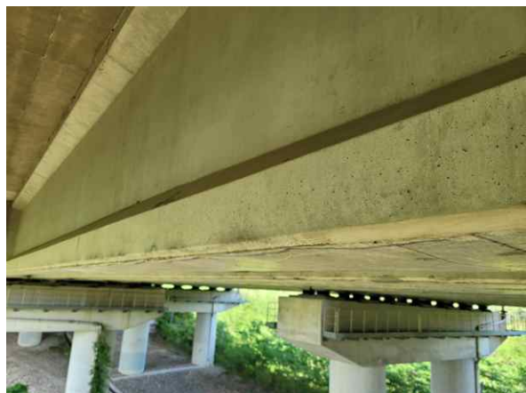
PSC Girder 전경
