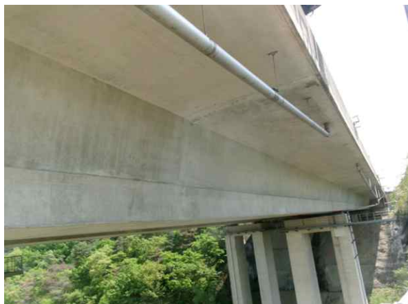
PSC BOX 외부 전경
